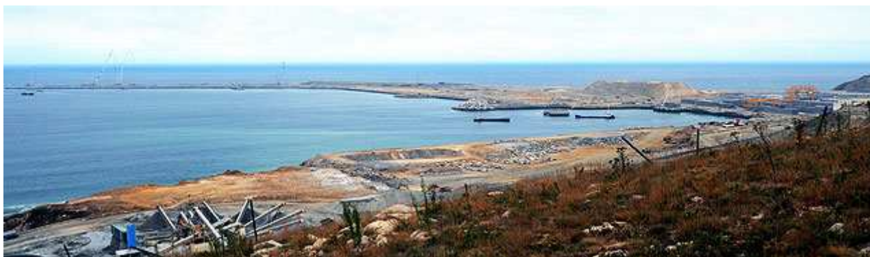
Estado de las obras de la dársena de Langosteira
