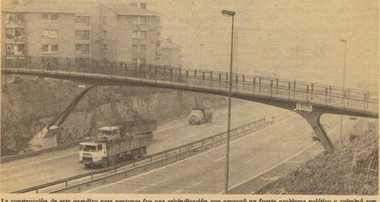
La construcción de este pasadizo para peatones fue una reivindicación que provocó un fuerte problema político y culminó con la dimisión de la alcaldesa de Bilbao. (Foto Imanol)
